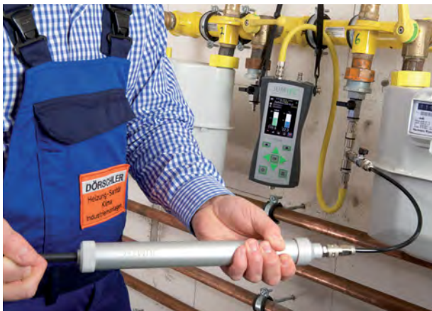
Dichtheitsprüfung 150mbar / Belastungsprüfung 1bar
